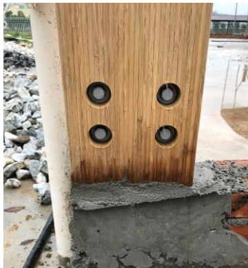
(d) Bolts connection side
