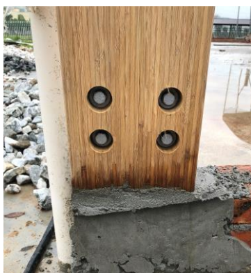
(d) Bolts connection side
